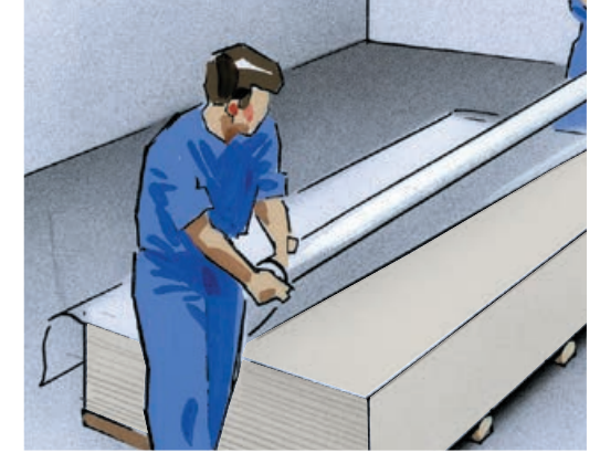
Kipsilevyjä ei saa vetää toistensa päällä. Nosta kipsilevy ja anna ainoastaan pitkän tai lyhyen sivun levätä alemmaa kipsilevyä vasten.
