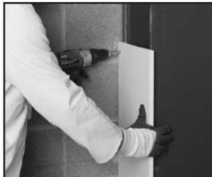
Esimerkki: 3-sivulta suojatun teräspilarin palosuojalevytyksen asennus käyttäen kulmalistaa
