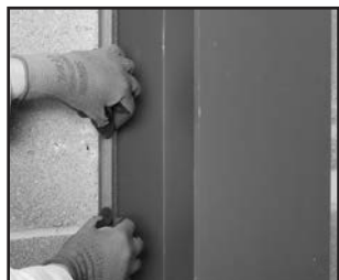
Esimerkki: 3-sivulta suojatun teräspilarin palosuojalevytyksen asennus käyttäen kulmalistaa
