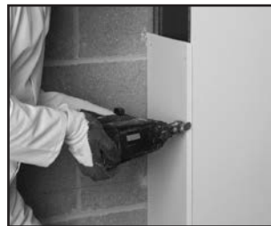
Esimerkki: 3-sivulta suojatun teräspilarin palosuojalevytyksen asennus käyttäen kulmalistaa
